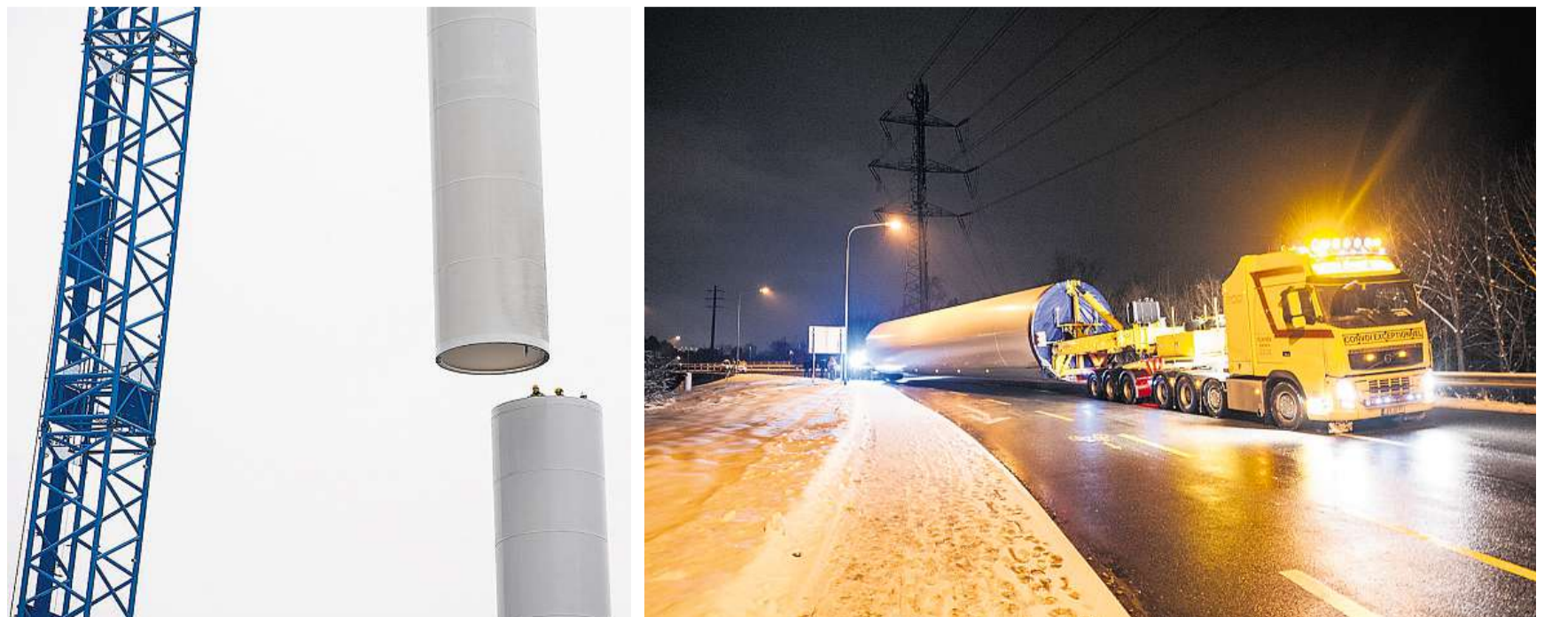
Arbeit für Spezialisten: Die «Turmkletterer» fügen in schwindelerregender Höhe zwei Turmsegmente zusammen, und der Chauffeur des Tiefgängers steuert sein mit einem weiteren Turmsegment beladenes Fahrzeug durch die engen Strassen.
